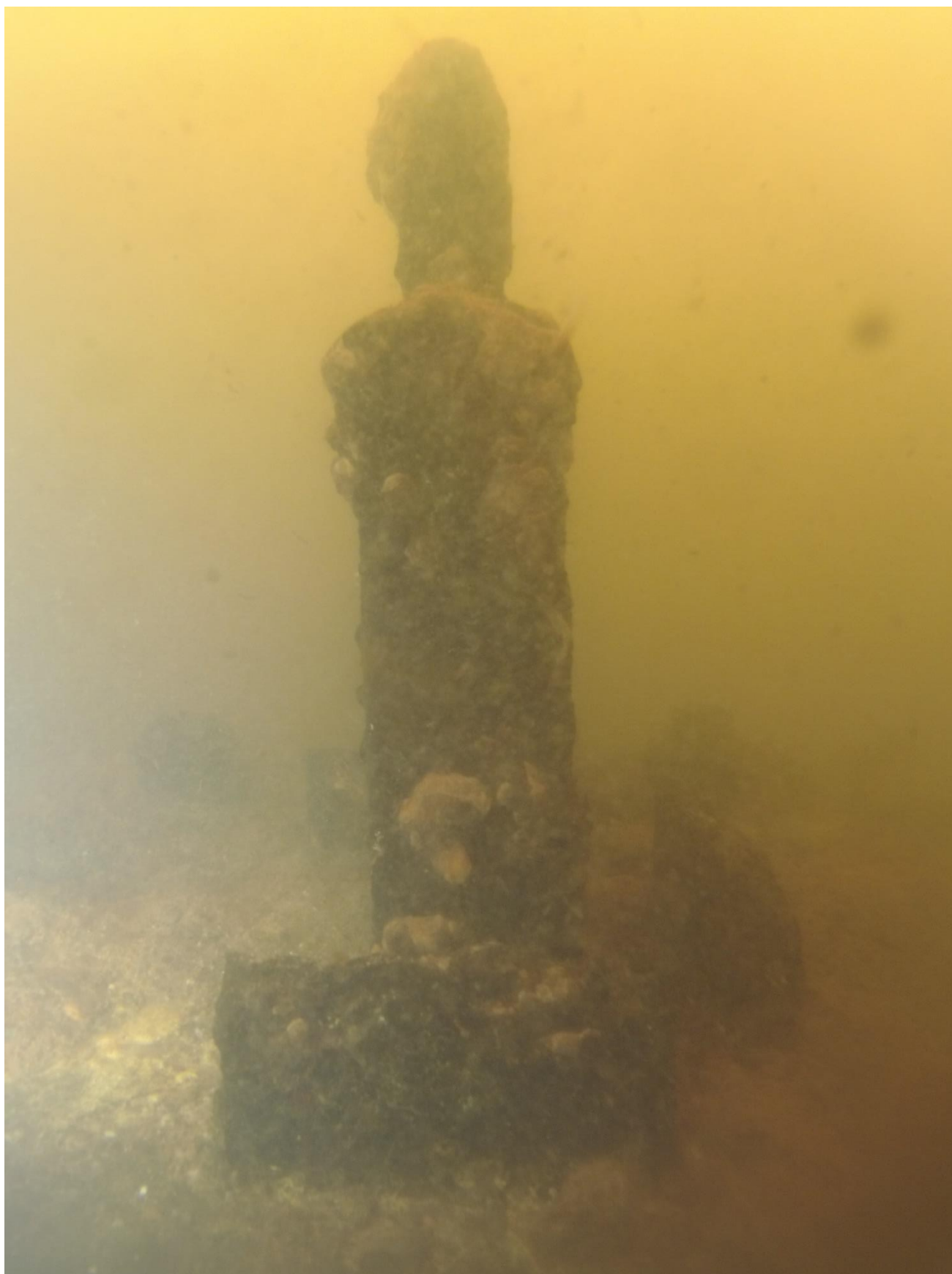
Foto: Ocelové oko pro usazení slupice středového jezového pole.
