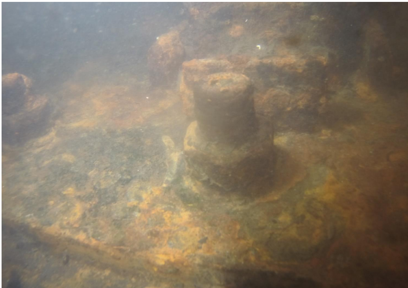
Foto: Uchycení ocelového oka.
