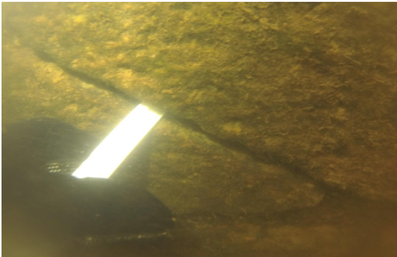
Foto: Porušené spárování v kamenném zdivu levého břehu u rybího přechodu.
