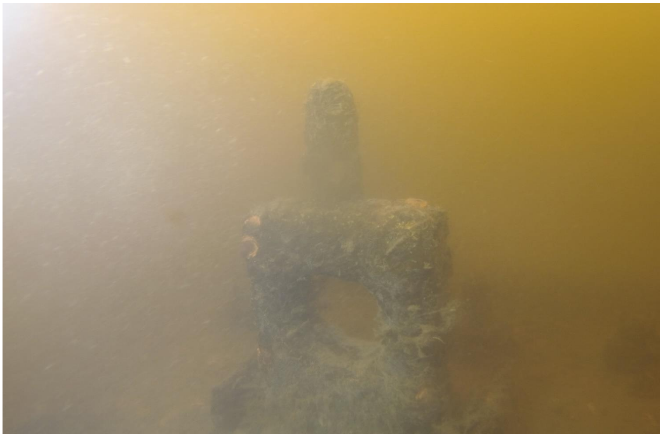
Foto: Ocelové oko na horní vodě levého jezového pole.
