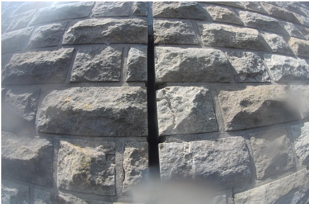
Foto: Vymazání dilatační spáry pomocí speciálního pružného tmelu.
