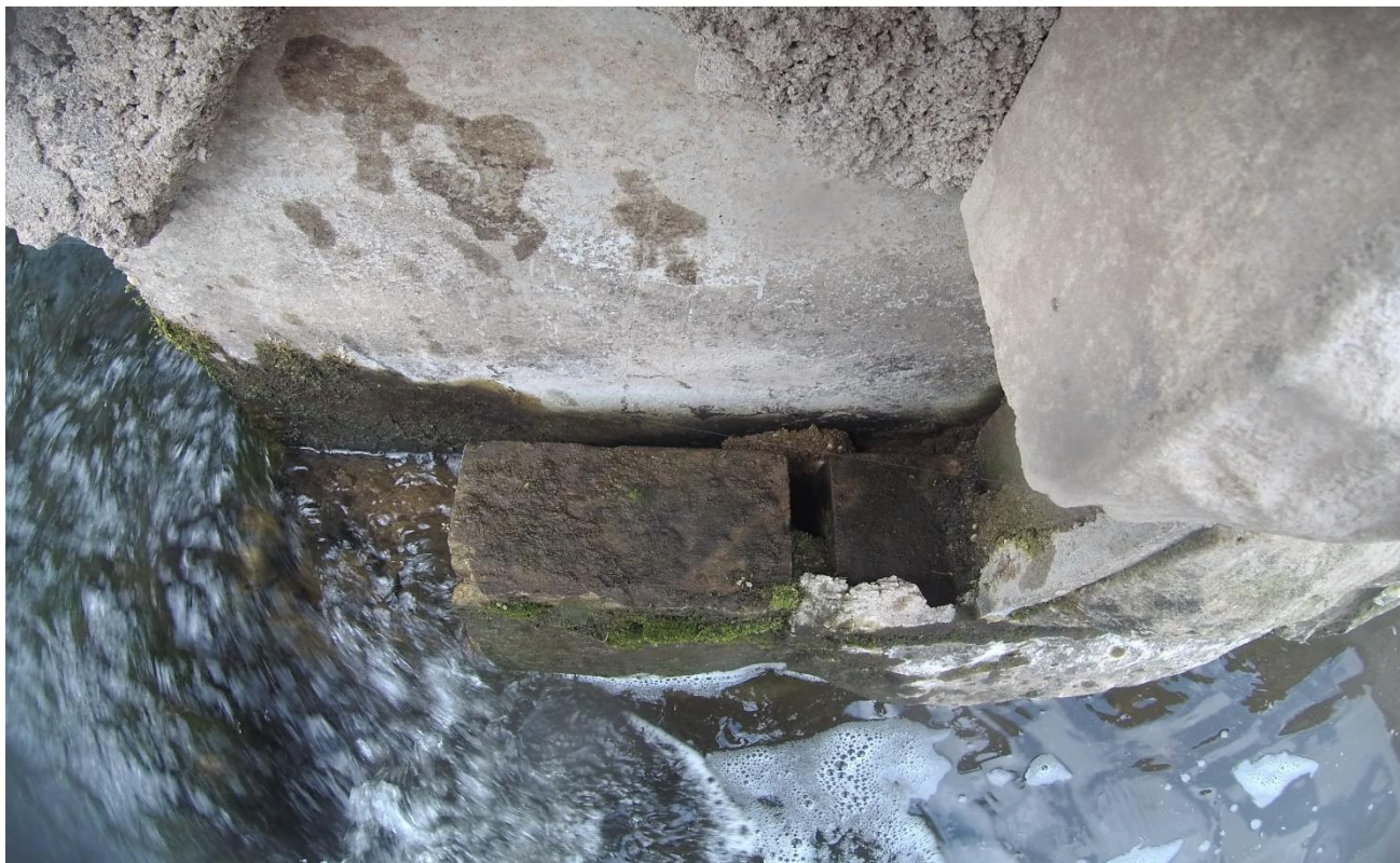
Foto: Chybějící kamenné kvádry a porušené spárování na dělicí zdi rybího přechodu.
