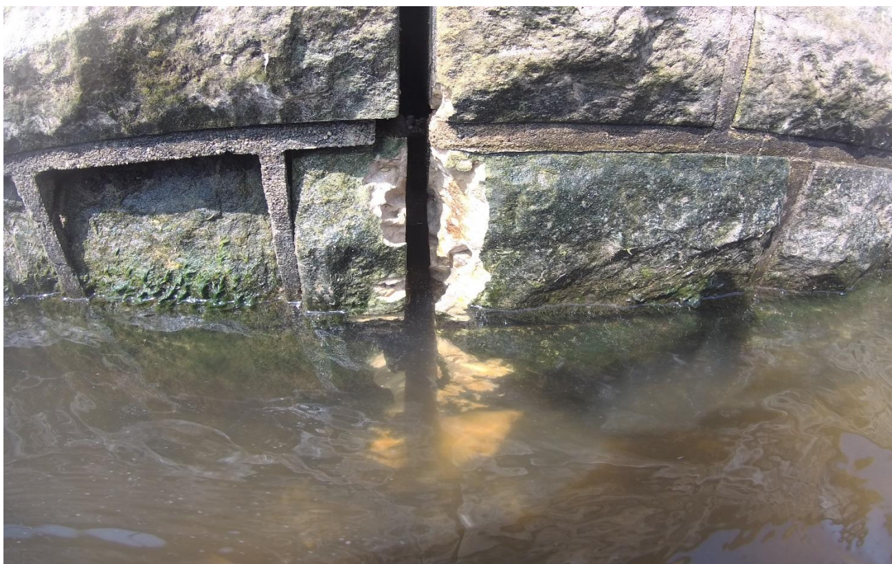
Foto: Očištěná dilatační spára.
