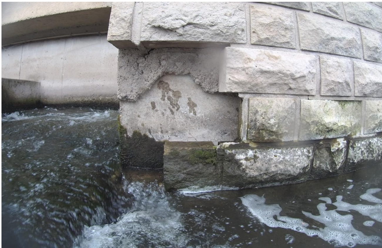
Foto: Chybějící kamenné kvádry na výtoku z rybího přechodu.
