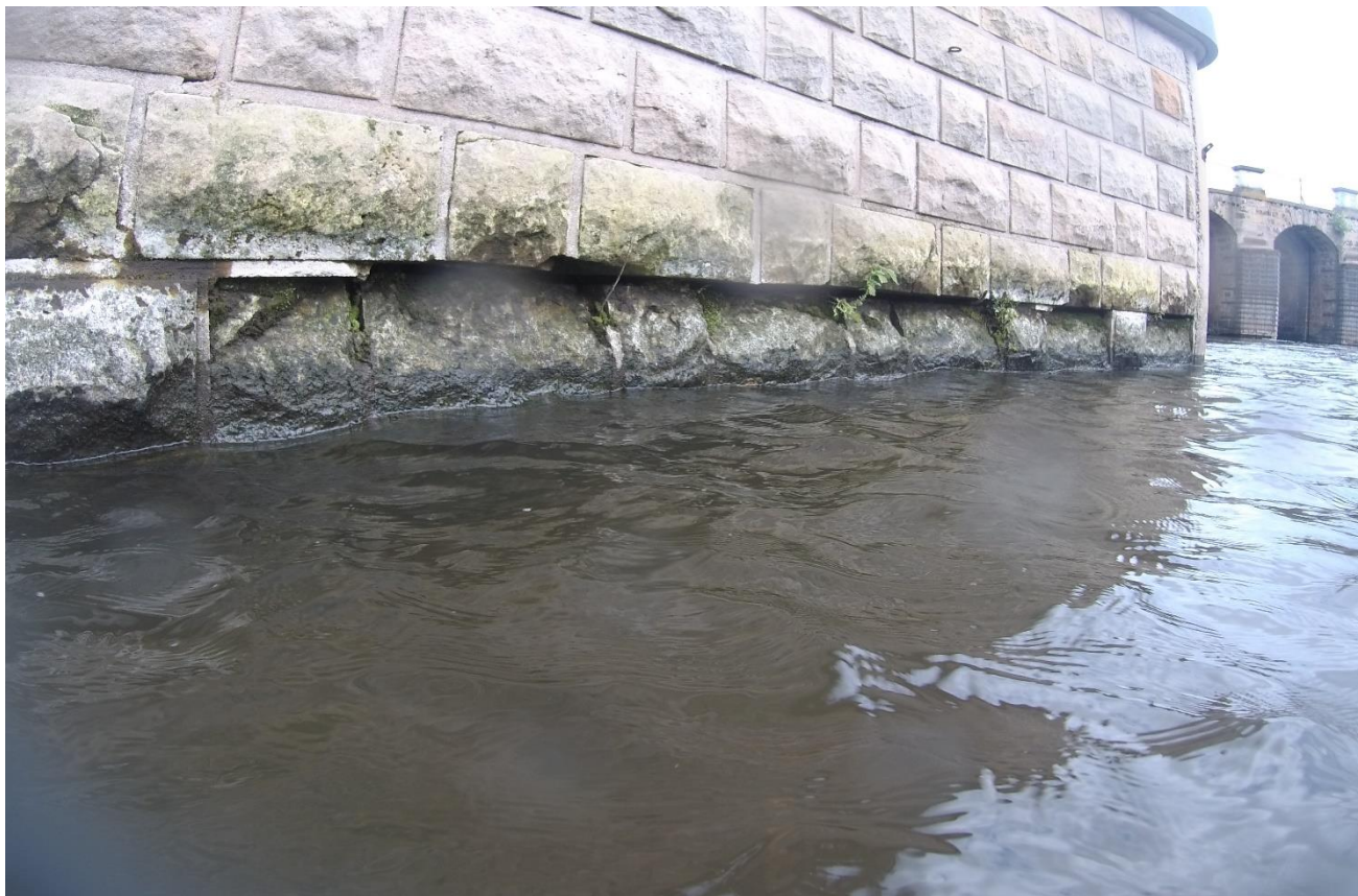
Foto: Dělicí zeď rybího přechodu a podjezí, vypadané kamenné kvádry.
