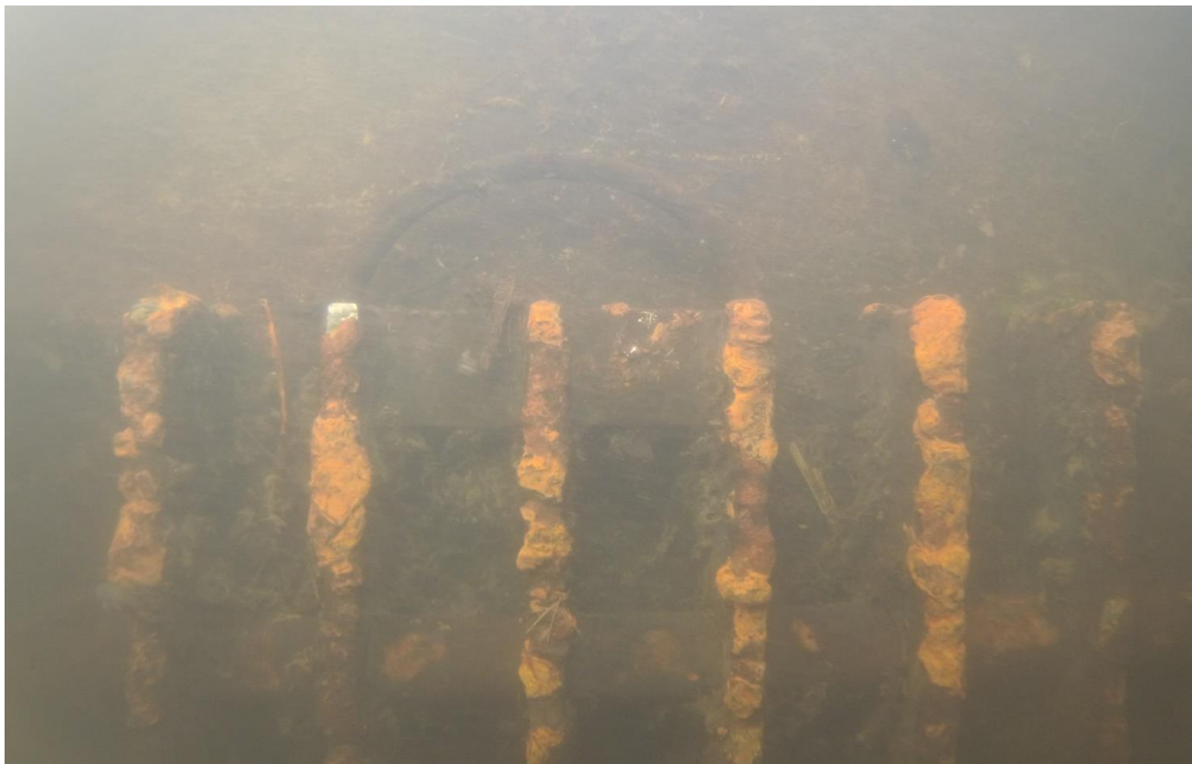
Foto: Očištěné česle nátoku do rybího přechodu.
