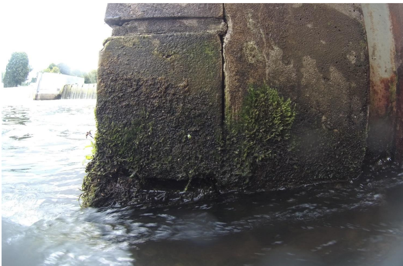
Foto: Porušené spárování kamenných kvádrů na dělicí zdi rybího přechodu.
