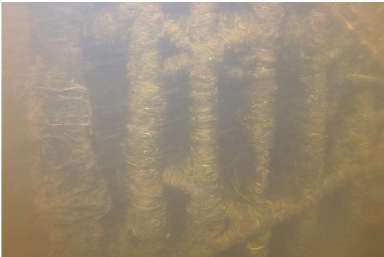
Foto: Neočištěné česle nátoku do rybího přechodu.
