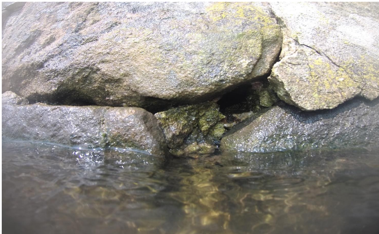
Foto: Porušené spárování v kamenném zdivu levého břehu u rybího přechodu.
