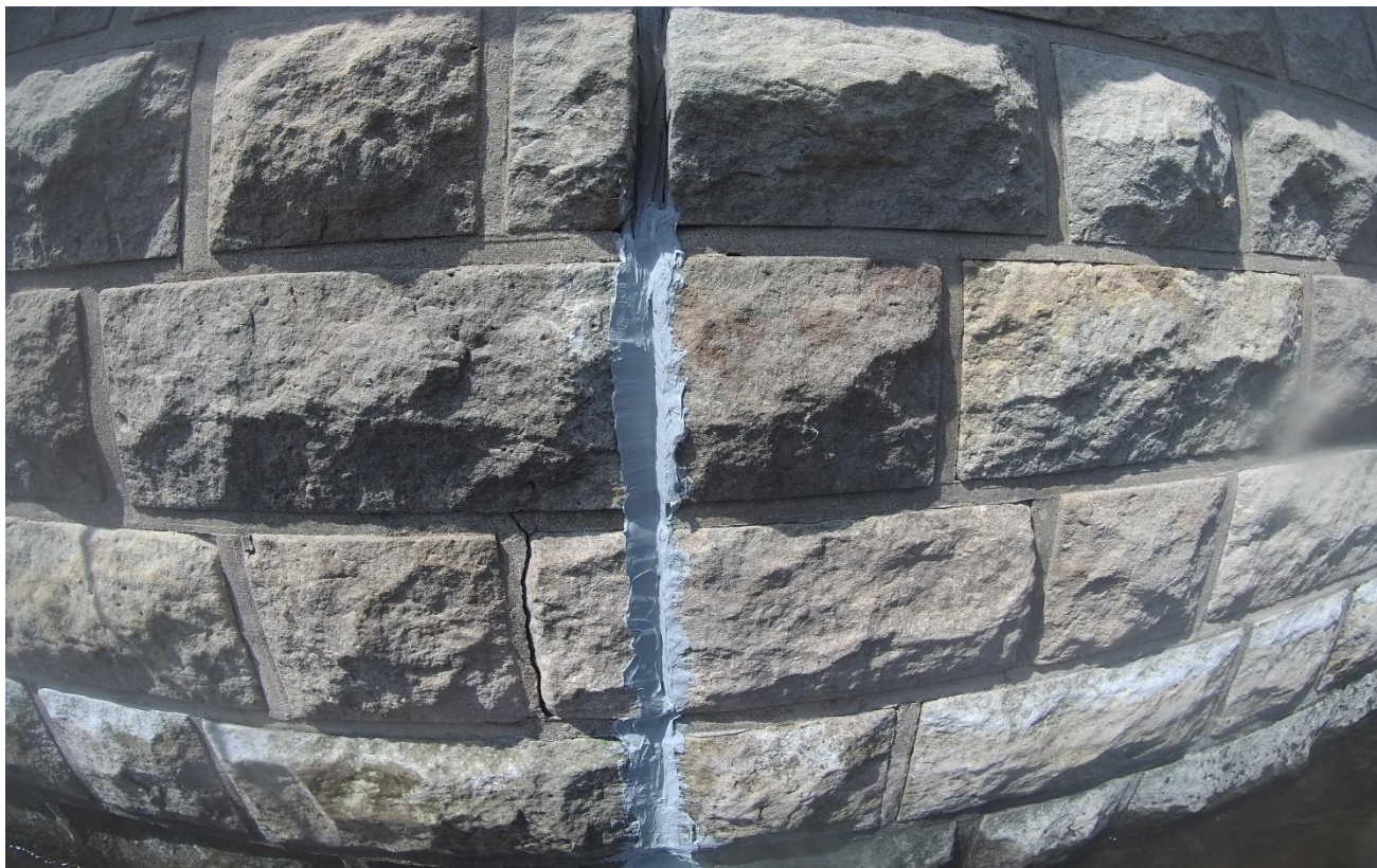
Foto: Zapravená dilatační spára nad vodní hladinou.
