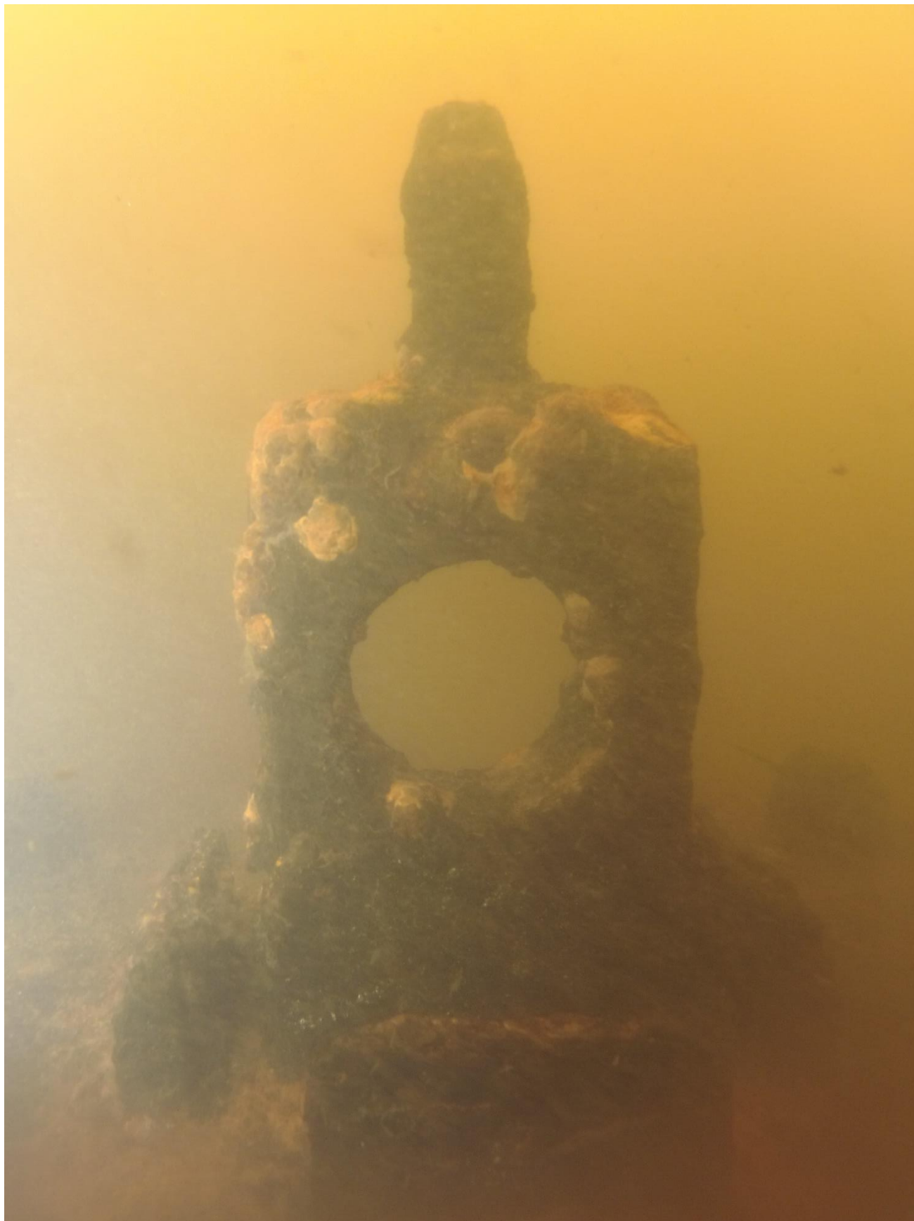
Foto: Ocelové oko na horní vodě středového jezového pole.
