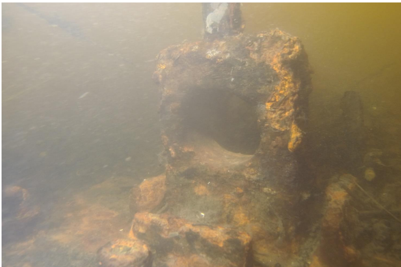
Foto: Ocelové oko pro usazení slupice na horní vodě levé jezového pole.
