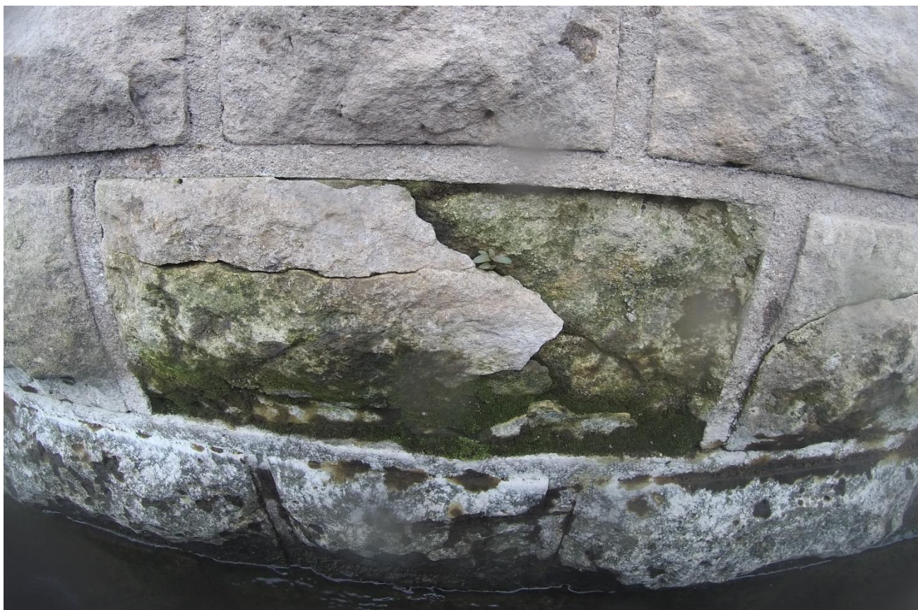
Foto: Narušená horní vrstva dělicí zdi u rybího přechodu.
