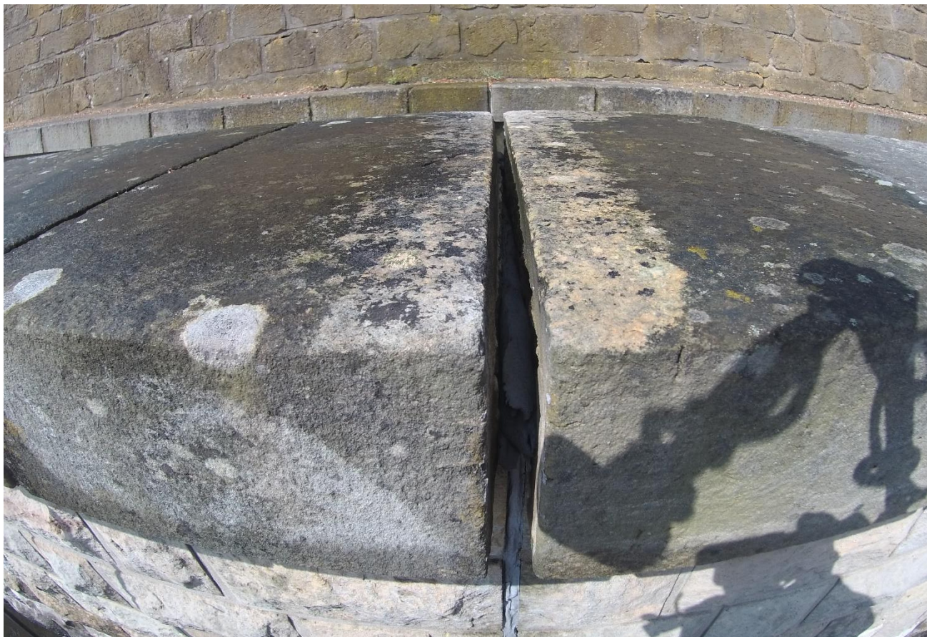
Foto: Očištěná dilatační spára.
