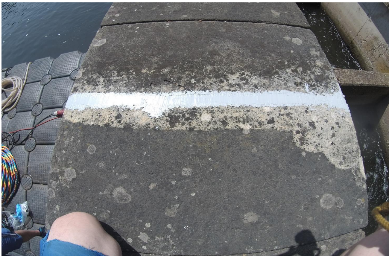
Foto: Zapravená dilatační spára.
