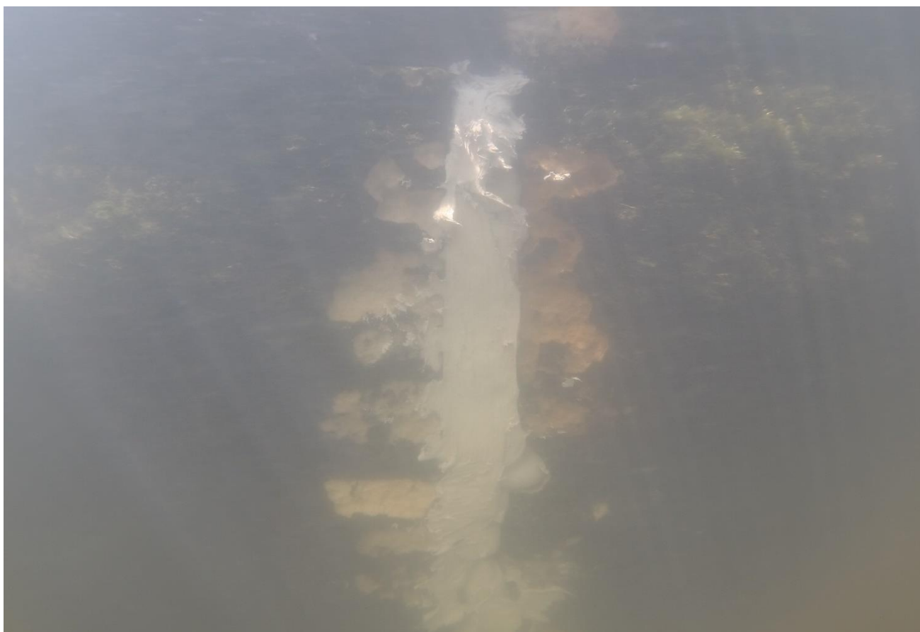
Foto: Zapravená dilatační spára pod vodní hladinou.
